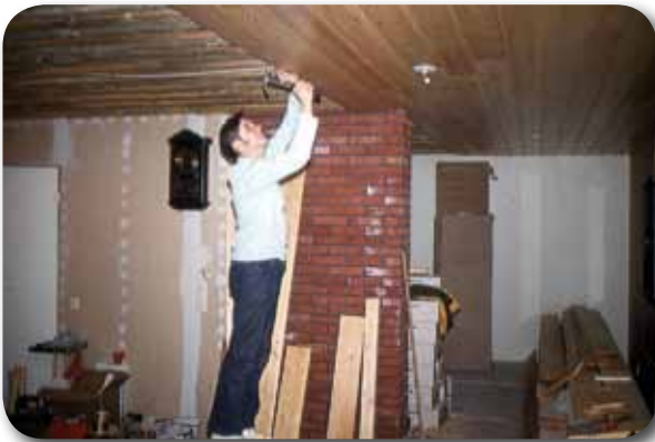
Kuva 102. Muuton jälkeen tehtiin vielä sisustustöitä.
